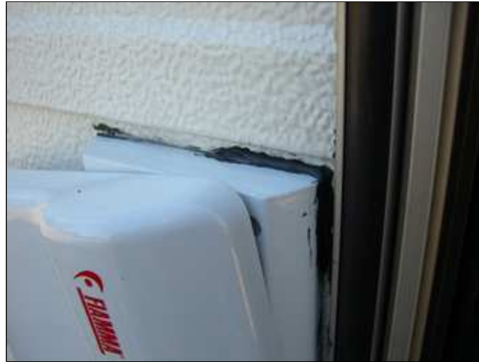
Einfach auftragen, überschüssiges Dekalin wird abgepöbelt Dicht !
