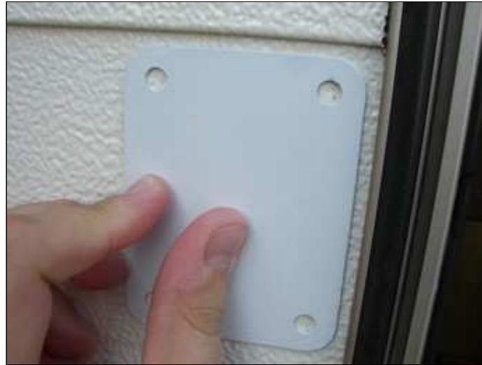
Mit einem Bleistift markieren wir nun die Bohrlöcher
