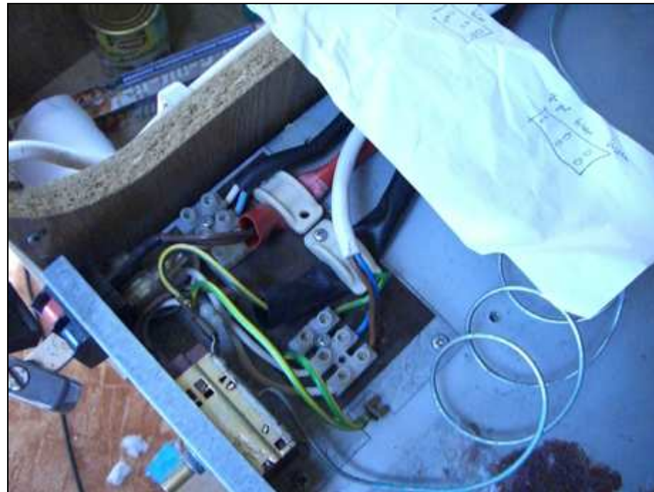
Kabel wieder anklebmen, gut, dass wir uns vorher die Belegung notiert haben
