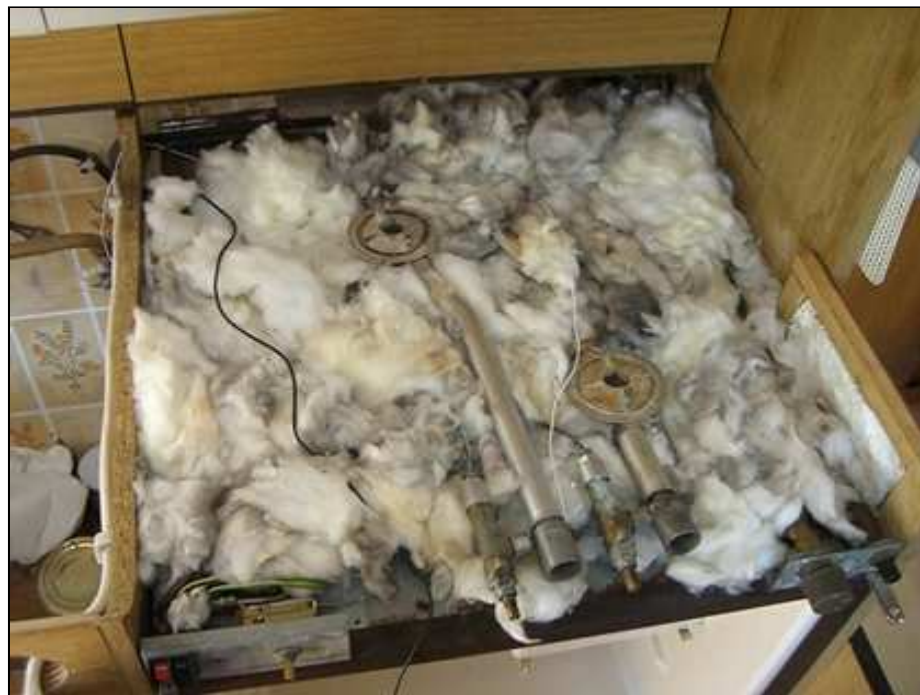
Spüle und Frontblende abgeschraubt, so sieht unser Kühli also von oben aus...
